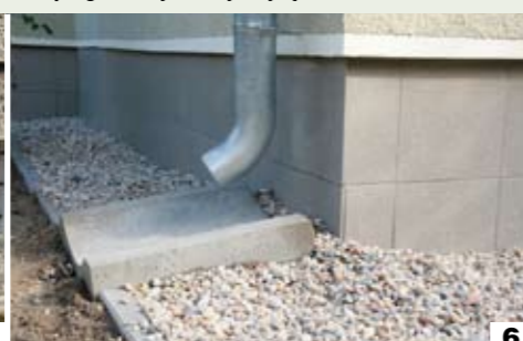
↑ Podziemną i nadziemną część ścian piwnicznych starannie ocieplono. Cokół oklejono szarymi płytkami gresowymi i otoczono opaską z grubego żwiru
