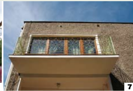
↑ Płyty balkonowe otulono dookoła wełną i wykończono podobnie jak ściany.
