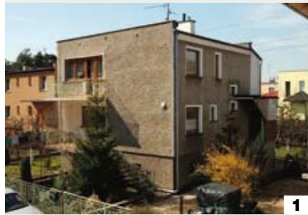
↑ Pod warstwą ocieplenia zniknął stary cementowy tynk o fakturze baranka. Nowy cienkowarstwowy tynk mineralny DR Ecorock pomalowano na jasno kremowo farbą silikonową
