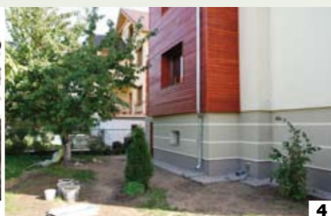
↑ Nieduża przybudówka na tyłach domu została ocieplona metodą lekką suchą. Jej elewację utworzyła oblicówka z desek modrzewiowych zaimpregnowanych olejobejca
