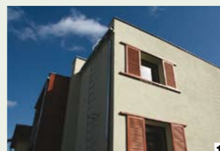
↑ przesuwne okiennice oraz ozdobne równoległe pasy, pozostawione w warstwie tynku
