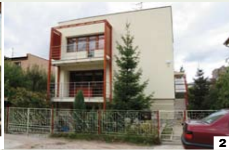
↑ Pod warstwą ocieplenia zniknął stary cementowy tynk o fakturze baranka. Nowy cienkowarstwowy tynk mineralny DR Ecorock pomalowano na jasno kremowo farbą silikonową
