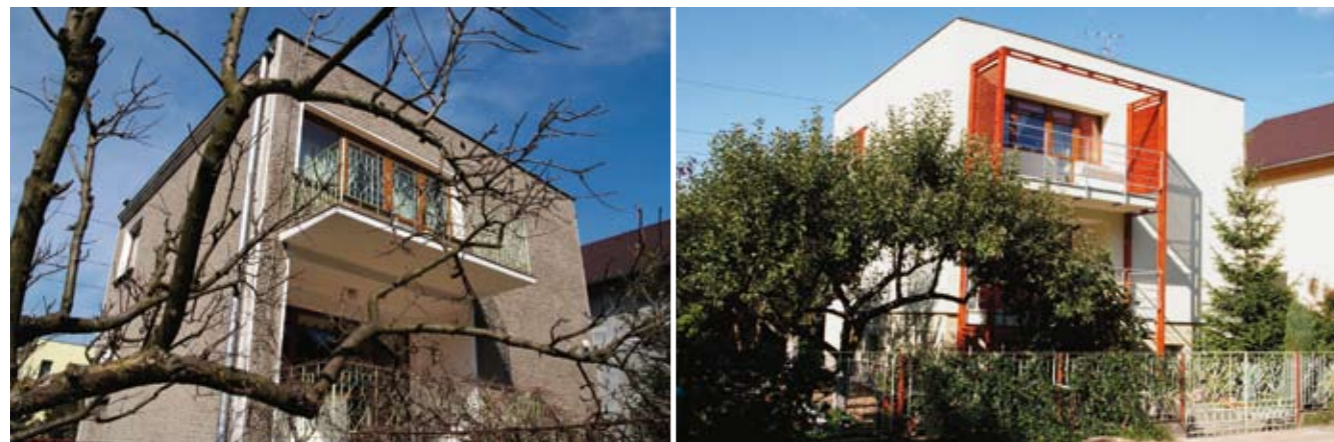
↑ Stary budynek wzniesiony w czasach budowlanego kryzysu nie wyróżniał się niczym poza wysokimi kosztami eksploatacji. Dziś dorównuje nowym budynkom, i to nie tylko wyglądem zewnętrznym
