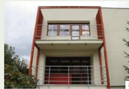
↑ Aby barierki nie przebijały warstw hydroizolacyjnych, podczepiono je do balkonu od spodu
