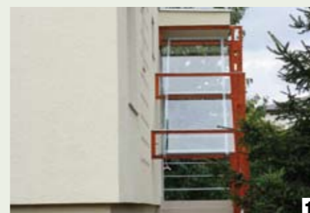
↑ stalowych ramach. Ocieplono i wykończono również daszek nad drzwiami
