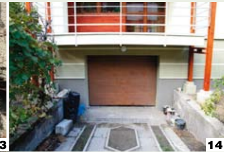
↑ Fot. 13 i 14 Starą drewnianą bramę garażową zastąpiono nową, o lepszych parametrach termoizolacyjnych
