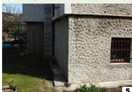
↑ Podziemną i nadziemną część ścian piwnicznych starannie ocieplono. Cokół oklejono szarymi płytkami gresowymi i otoczono opaską z grubego żwiru
